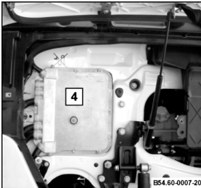
④ Tampa da central elétrica
