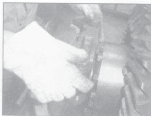
установить крышку подшипника
