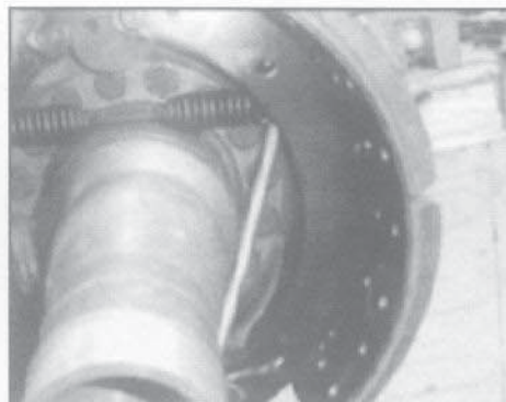
демонтаж тормозного копыта
