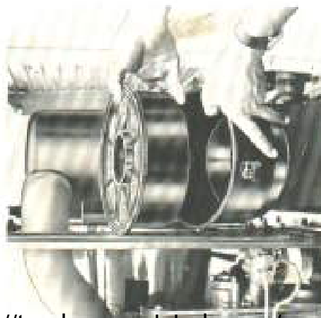
FIG. 12. Apertura filtro olio verifica livello
