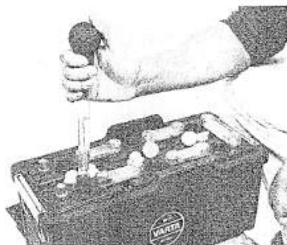
FIG. 45 - Contrôle de la charge de la batterie avec un densimètre
