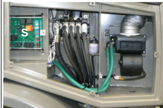
Fig.4.5 Reparaturarbeiten an der elektrischen Anlage
