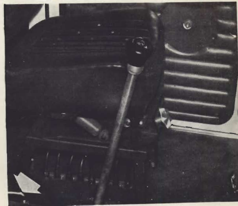
Fig. 1.9. - Interruptor general baterías
