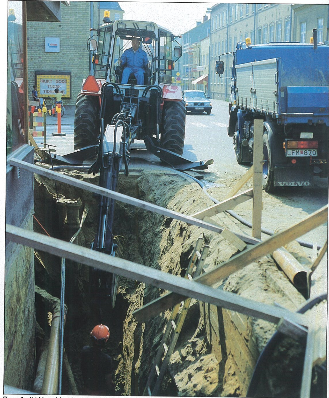
Bra närsikt i kombination med exakt manövrering ökar säkerheten vid grävning på trånga utrymmen t.ex. i stadsmiljö.
